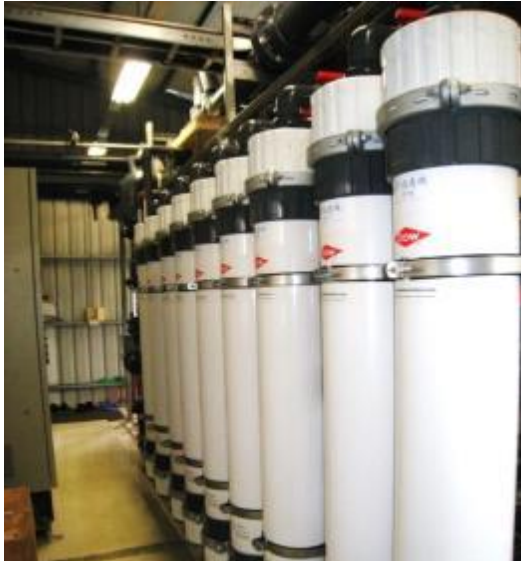
切割研磨廢水回收膜管更換為 DOWEX 膜
