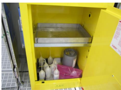
化學品貯存櫃設置防漏承接盤
