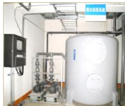
↑ 建置雨水回收系統
