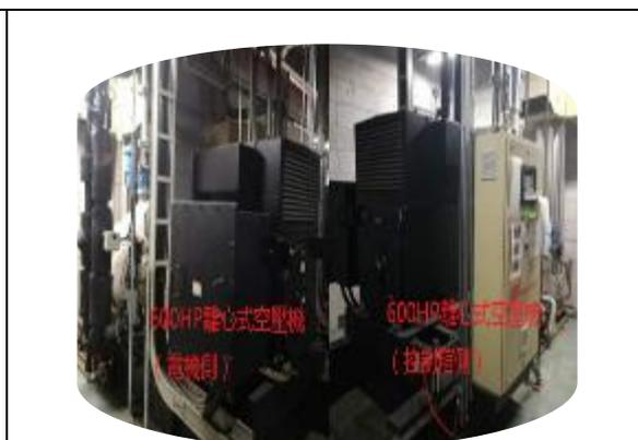
離心式空壓機替代螺桿式空壓機(京隆)
